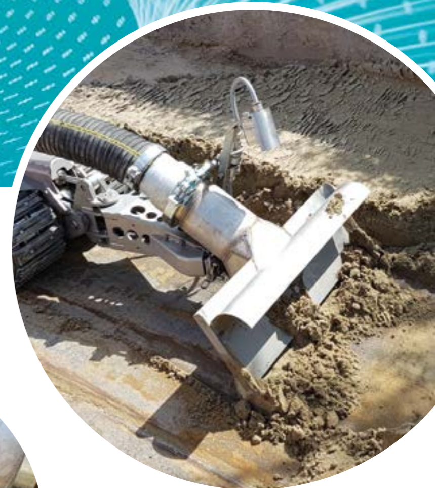
ADEX-Robot für die Grobreinigung von Flachbodentanks in der ATEX-Zone 0
